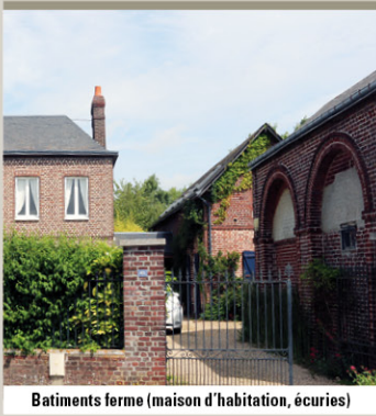
Bâtiments ferme (maison d'habitation, écuries)
