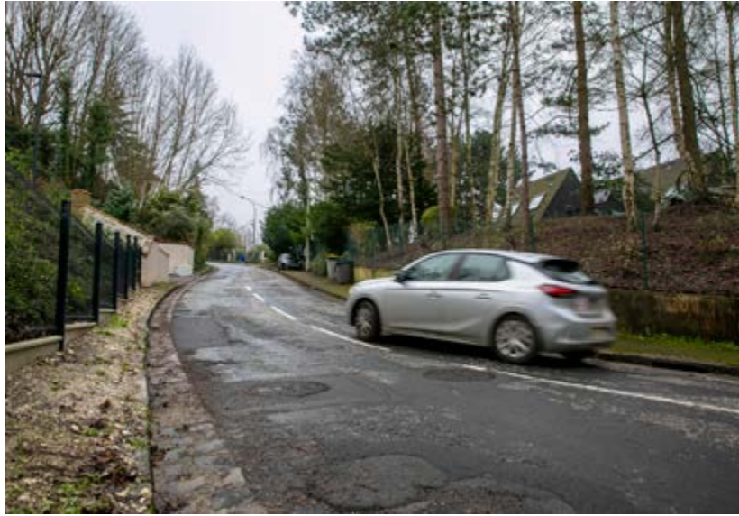
*** La rue des Cèdres, et notamment le bas de la voie qui est particulièrement détériorée, va bénéficier d'importants travaux en février.
