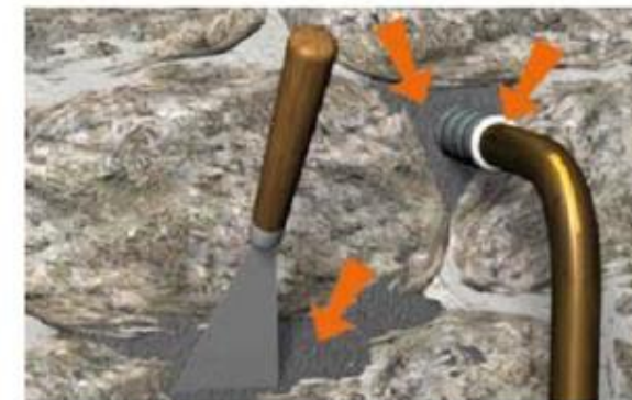
Situation après travaux : colmatage des voies d'eau.
